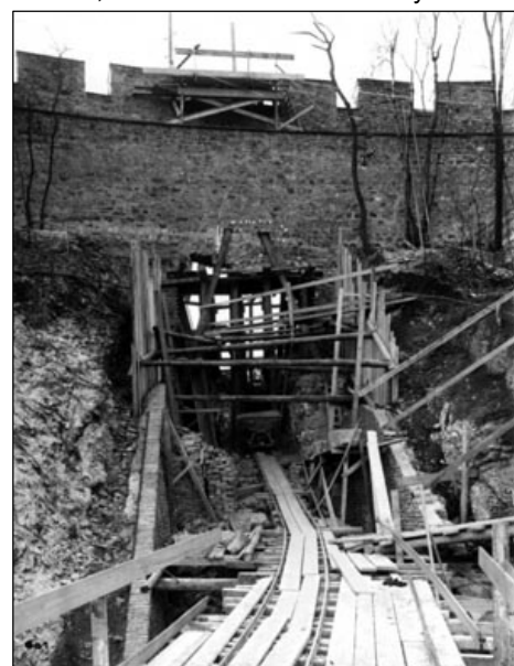
Průlom Hladové zdi pro prodloužení dráhy, 1931
