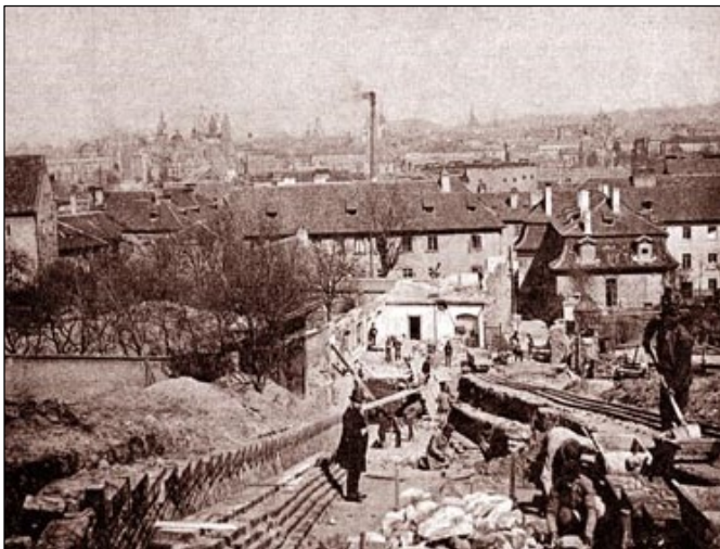
Staveniště dolní stanice lanové dráhy ve stavu ke dni 1. května 1891
